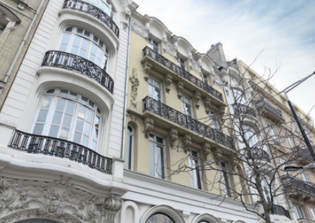
Immeuble de la Compagnie générale transatlantique, boulevard de Strasbourg, Le Havre
